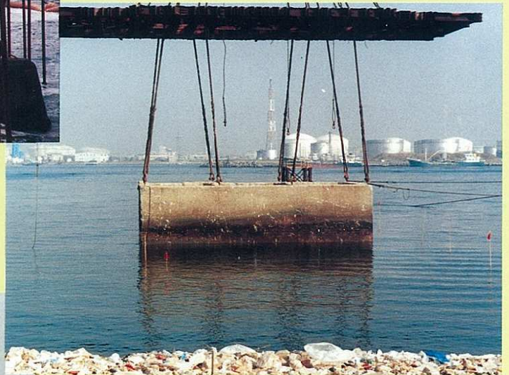
⤴ φ42×800㎜ ケーソン撤去工事 300 t / 8ヶ所
