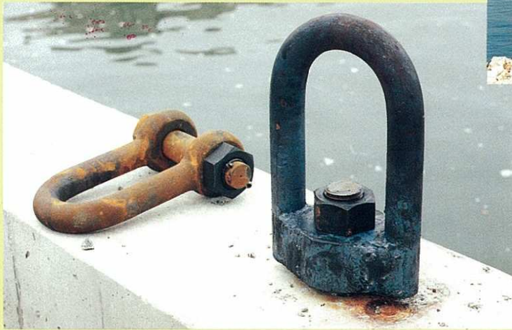
⤴ φ52×450㎜ 既存岸壁補修工事 160 t / 12ヶ所
