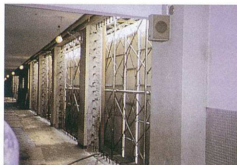
接着系あと施工アンカー打設後
