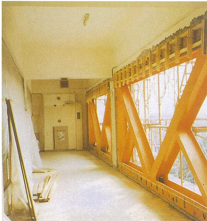
無収縮モルタル圧入用型枠組立状況
