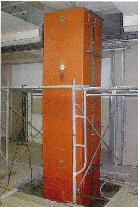
鋼板による柱補強
