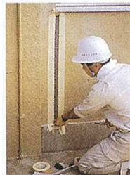
バックアップ材充填 マスキングテープ設置工
