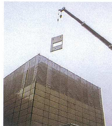
ラフターによる搬出
