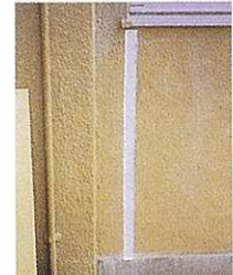
耐震スリット工事完了
