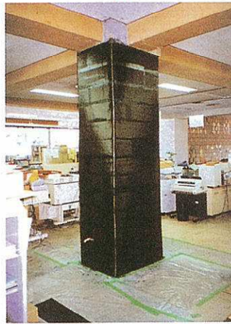
炭素繊維シート巻付終了
