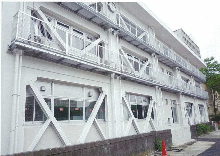
某大学耐震補強(ハイブリッド工法)
