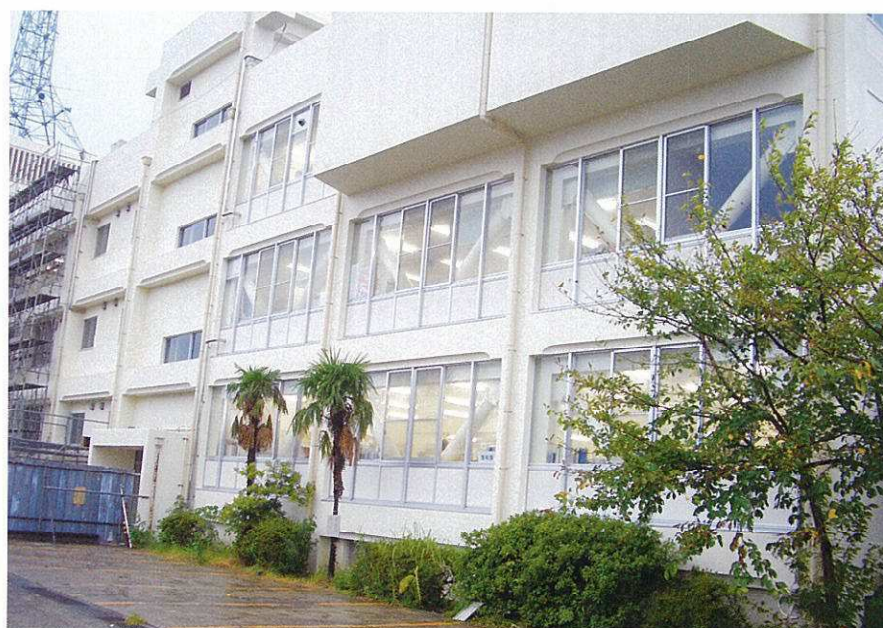
某総合庁舎耐震補強
