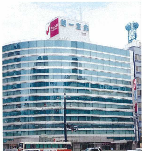
某民間ビル耐震補強
