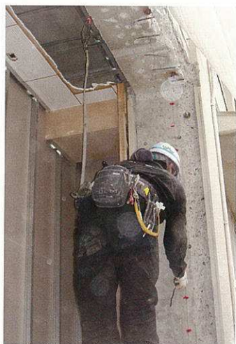
接着系あと施工アンカー 墨出状況
