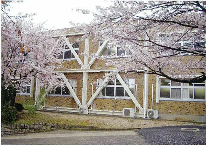
某診療所耐震補強
