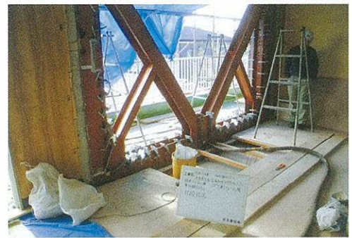
無収縮グラウト圧入状況
