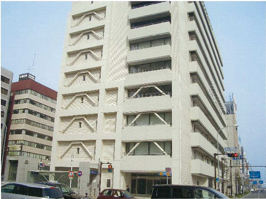
某公共施設耐震補強
