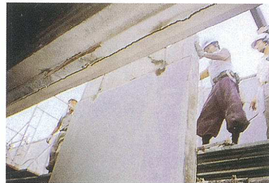
躯体搬出状況
