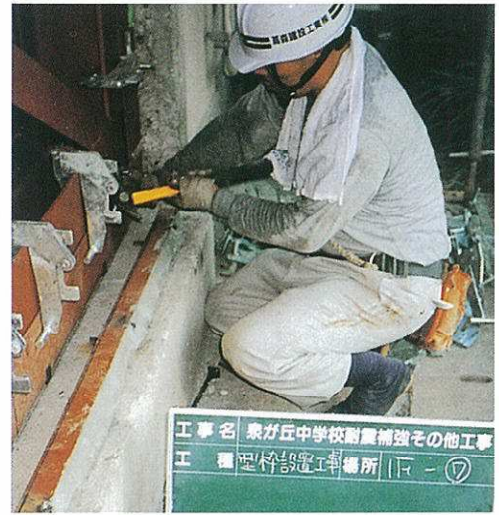
鋼板型枠取り付け状況
