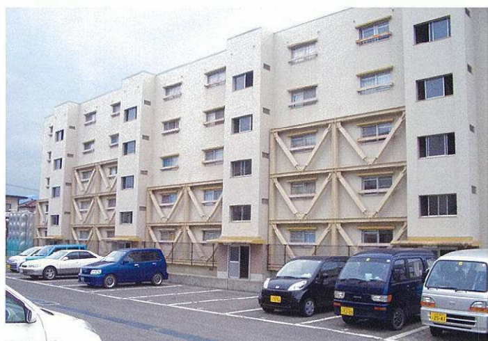
某集合住宅耐震補強
