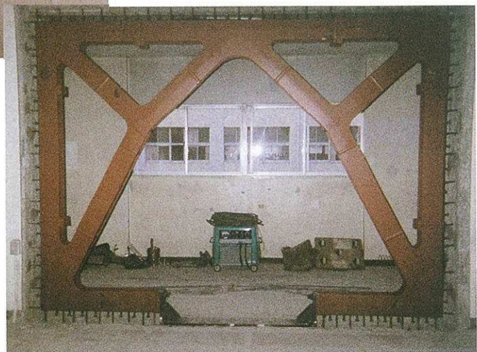
出入口を持つ鉄骨補強
