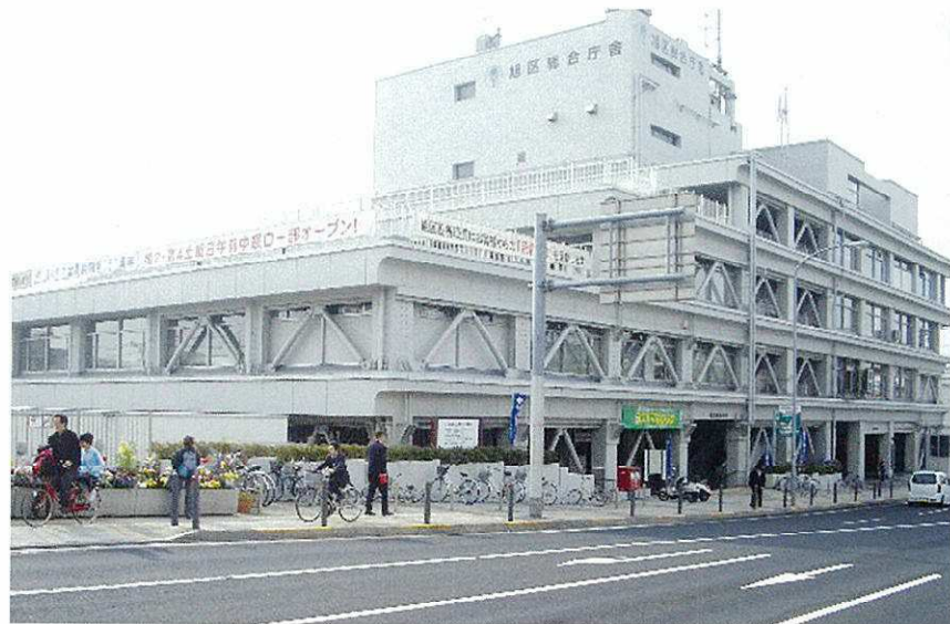
某庁舎耐震補強
