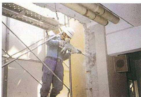
躯体手ハツリ状況
