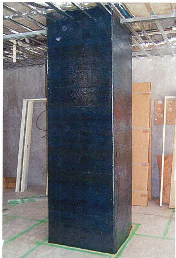
炭素繊維シートによる柱補強
