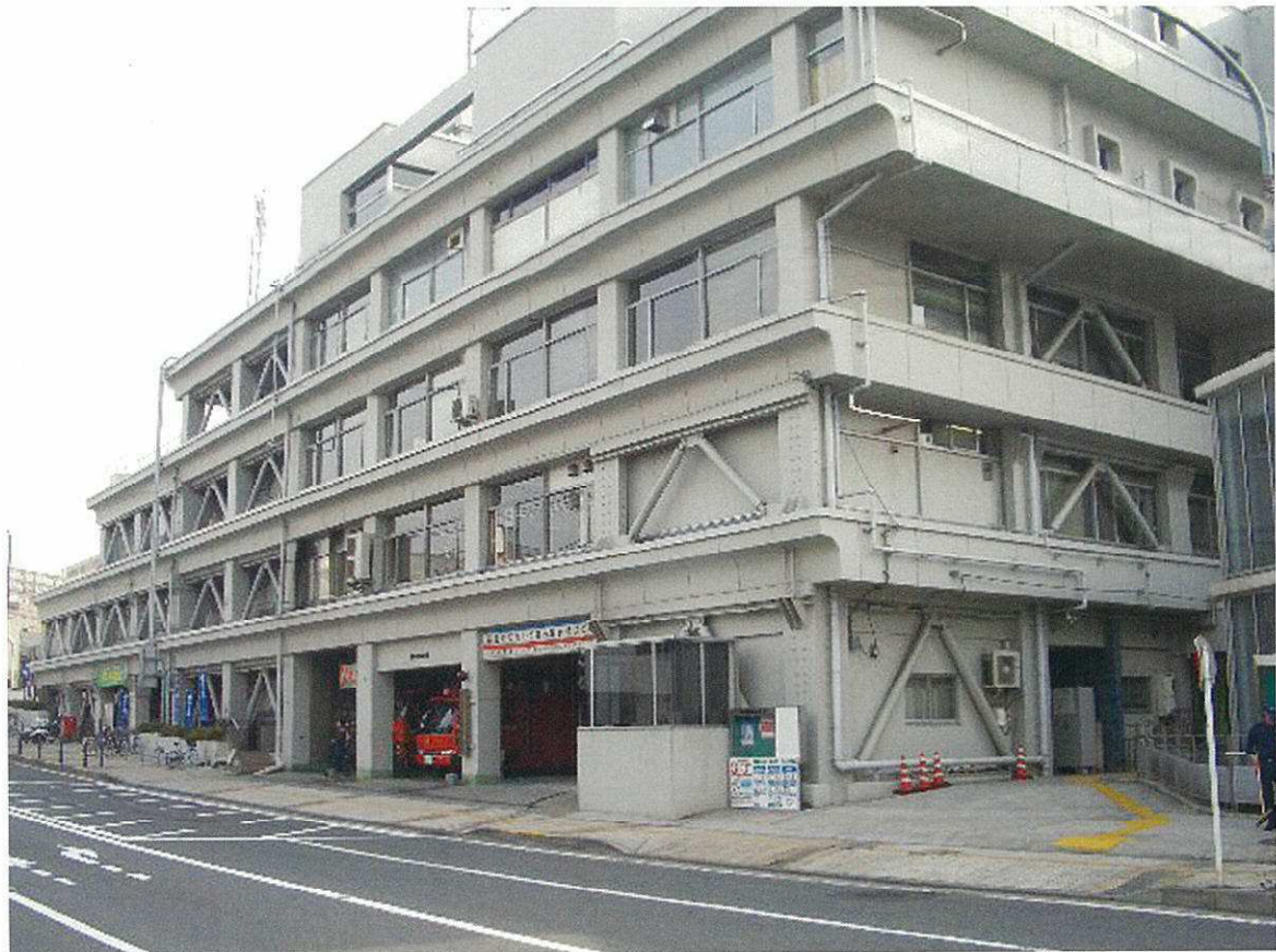
KTブレース工法
