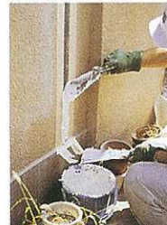
コーキング材充填工
