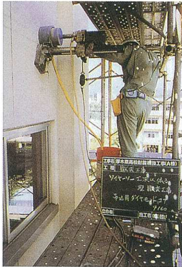
躯体搬出用コア穿孔
