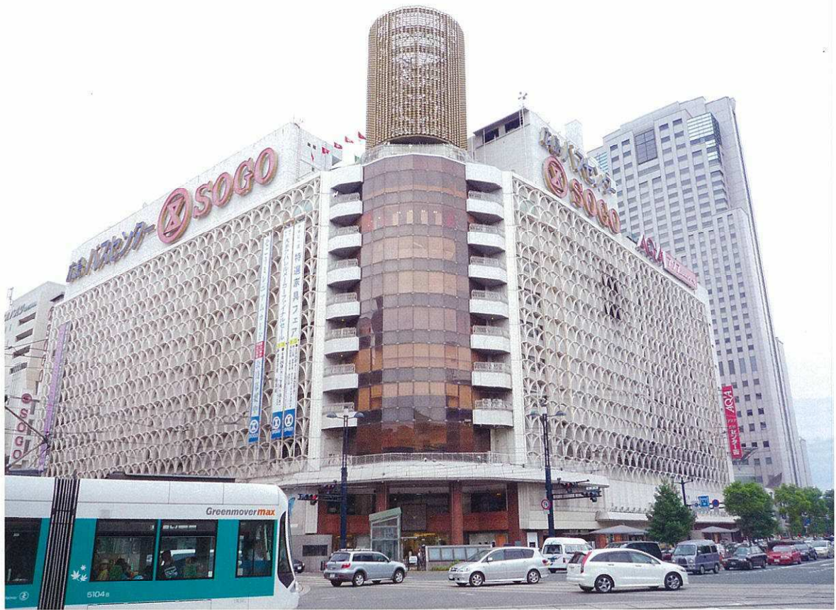
某百貨店耐震補強
