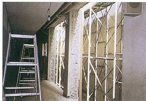
接着系あと施工アンカー打設前
