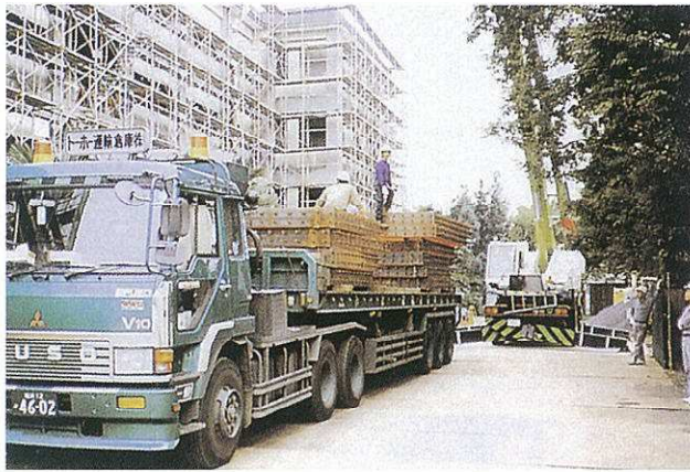
トレーラーによる鉄骨ブレース搬入状況 (レッカー車が待機中)
