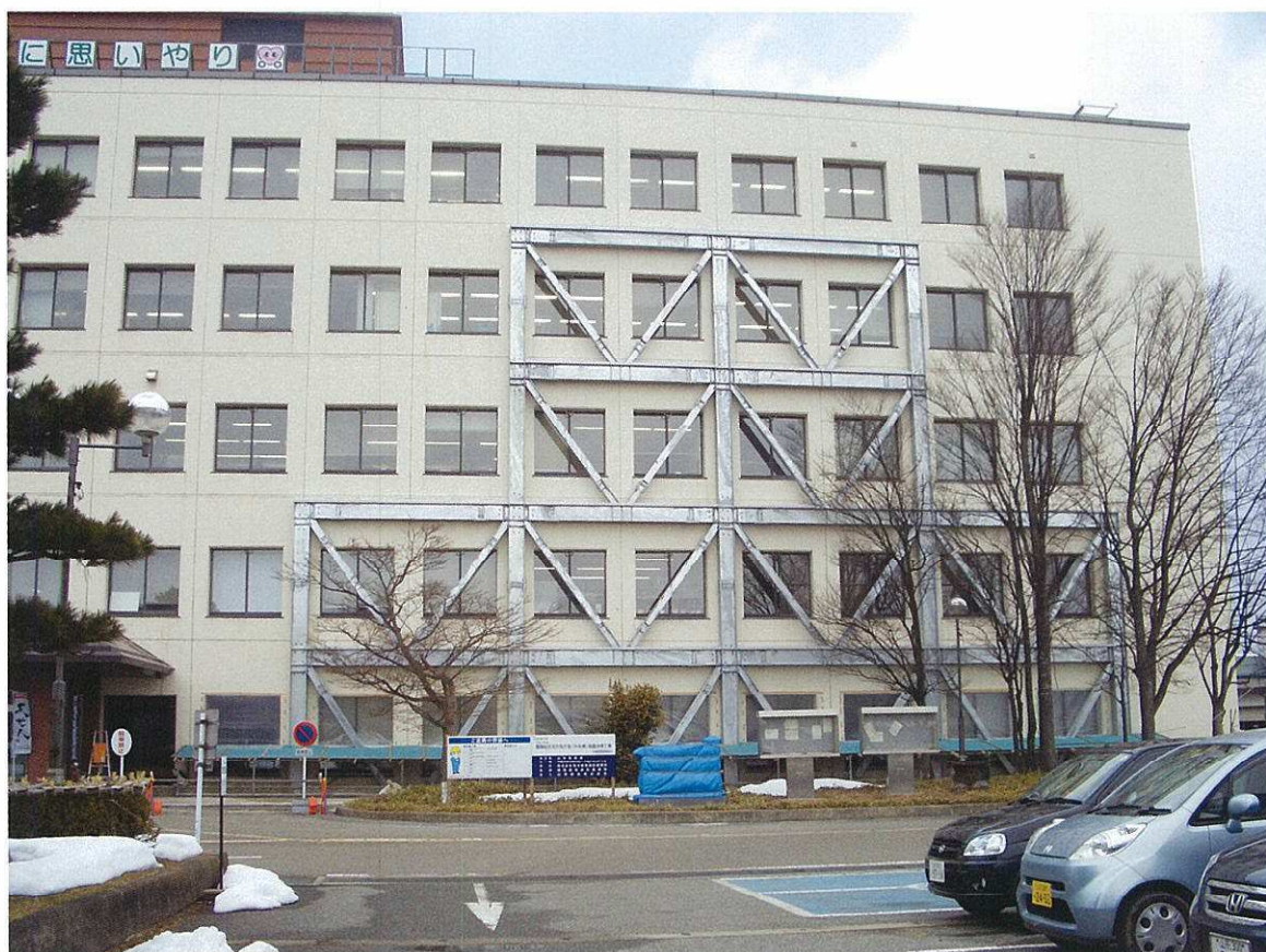
外付鉄骨ブレース工法
