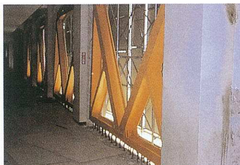
鉄骨ブレース収まり状況
