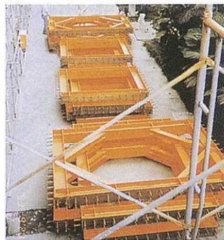
鉄骨ブレース吊り込み前仮置き状況
