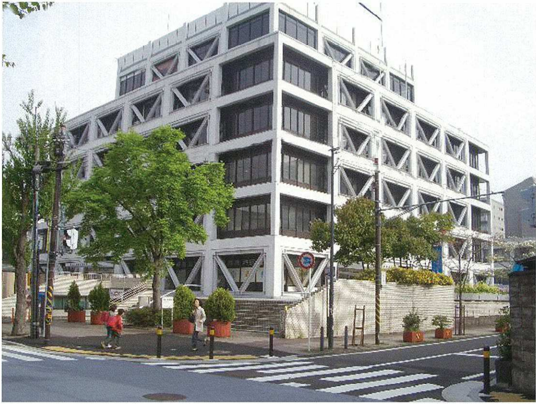
某庁舎耐震補強
