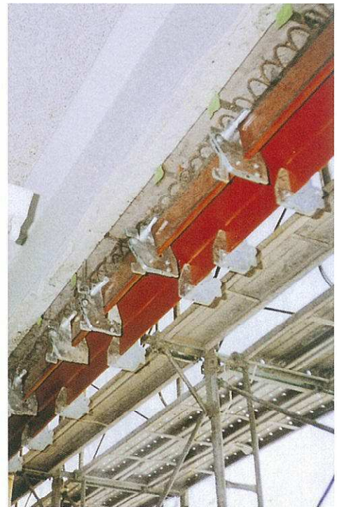
透明板型枠を用いた鋼製型枠組立工法
