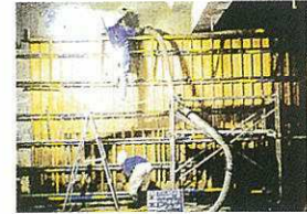
コンクリート打設
