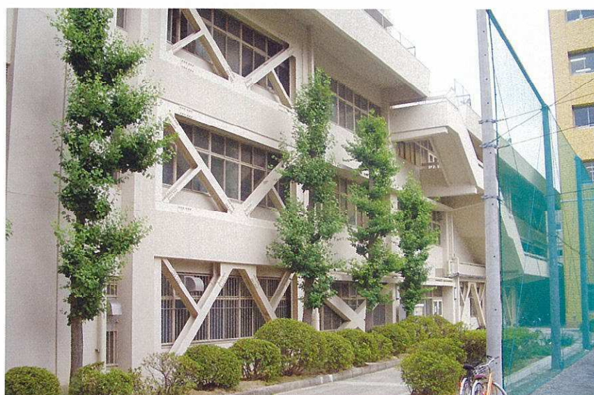
某学校耐震補強
