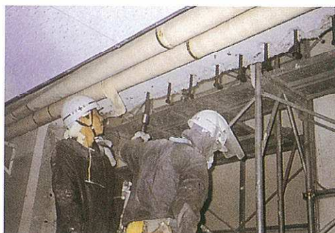
接着系あと施工アンカー打設状況
