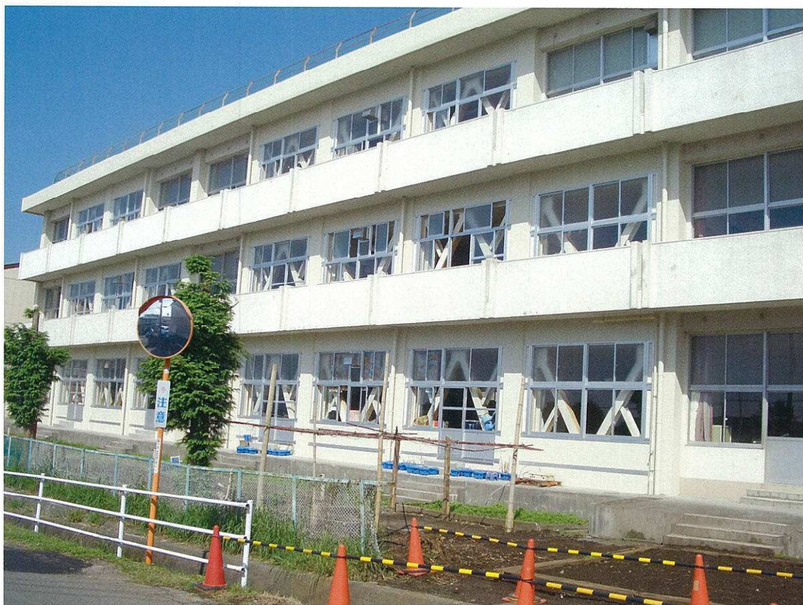
在来工法 (K型ブレース)
