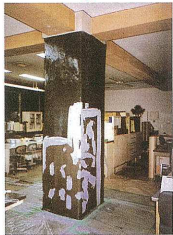
パテ処理プライマー塗布状況
