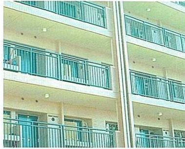
手摺・フェンス取付
