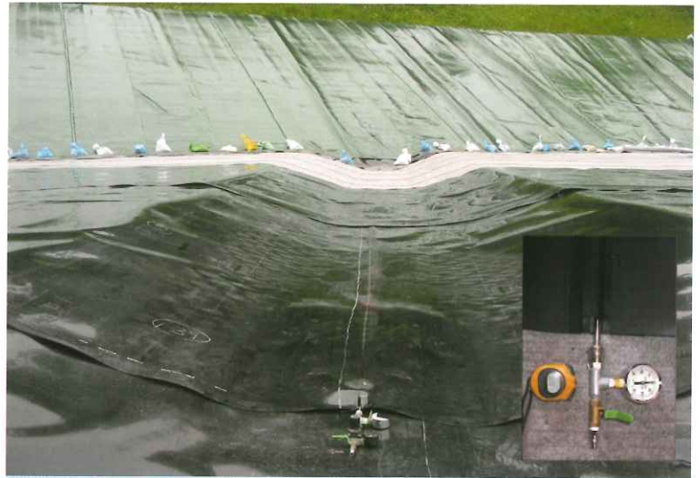
接合部加圧検査
