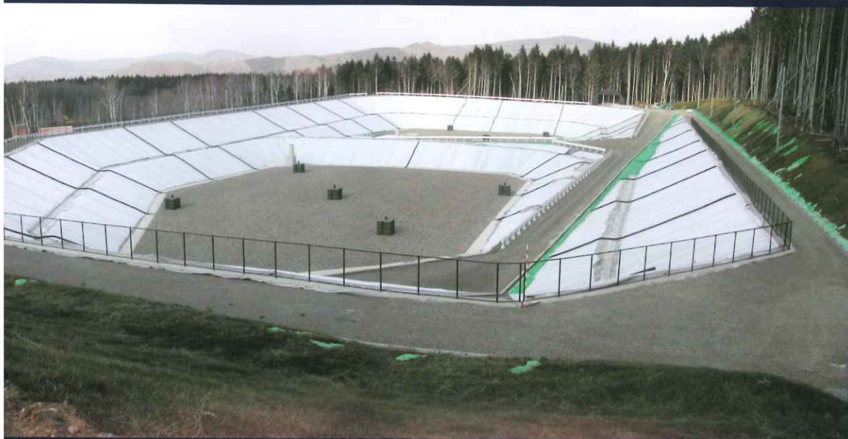
留辺蘂町外2町一般廃棄物最終処分場 (PFI事業)
