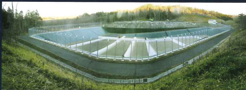
厚岸町一般廃棄物最終処分場(第2期埋立地)建設工事
