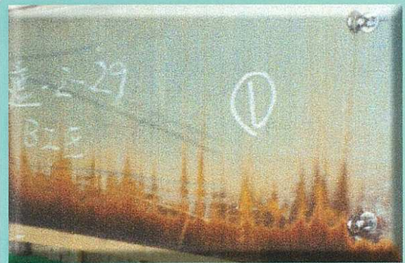
高速道路遮音壁改築工事
