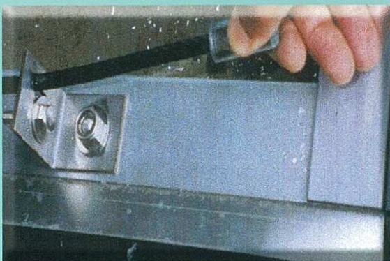
道路透光板改良工事
