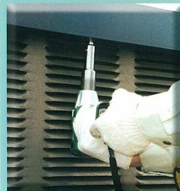
高速道路笠木改良工事
