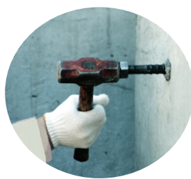
打込み型 (手ハンマーによる打設)
