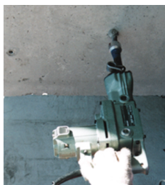
回転・打撃型 (ハンマードリルによる打設)
