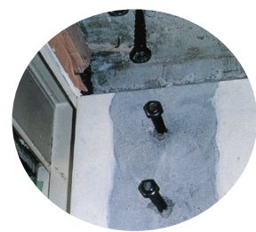
打設後のアンカー状況
