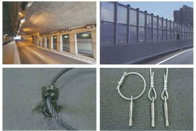
ホーク・タイワイヤーアンカーZ設置状況
